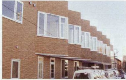
自然採光に配慮した病棟
